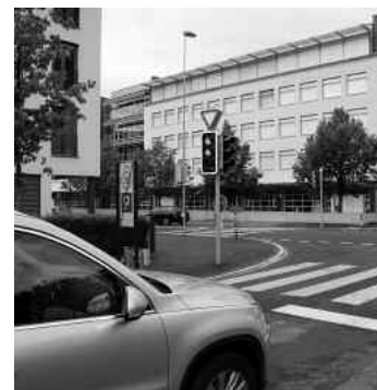
Die Kreuzung Göblistrasse/Industriestrasse ist saniert und den neuen Gegebenheiten angepasst worden...
