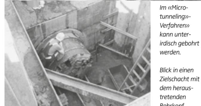
Im «Micro-tunneling»-Verfahren kann unterirdisch gebohrt werden.
